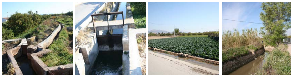
Fig. 34. Sistema de riego de la Huerta de Murcia. A: Azud de Contraparada. B: acequia Aljufía. C: Acequia menor. D: Brazal. E: Regadera.
